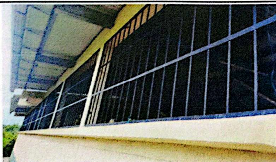
Foto 5: Mantenimiento a balcones
