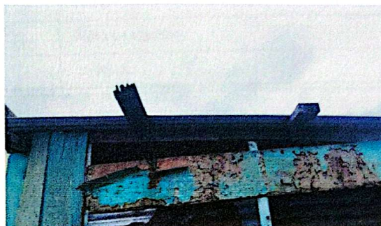
Foto 2: Estructura de soporte de metal
