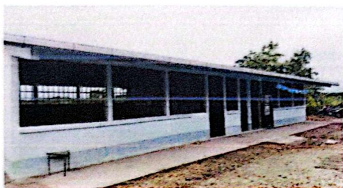
Foto 7: Pintura en muros
