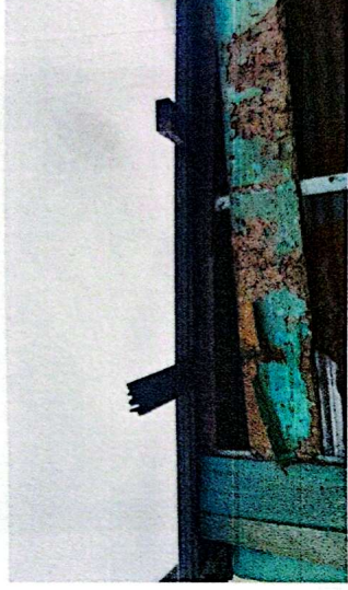
Foto 2: Estructura de soporte de metal
