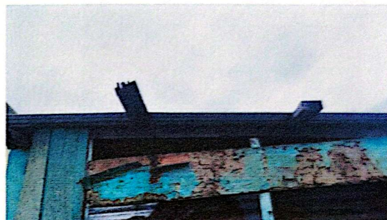
Foto 2: Estructura de soporte de metal
