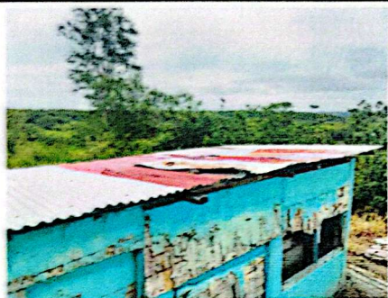
Foto 1: Sustrucion de Lámina
