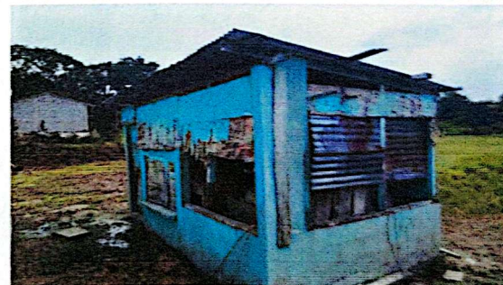
Foto 4: Sustrucion de Ventana
