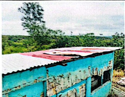
Foto1: Sustrucion de Lámina
