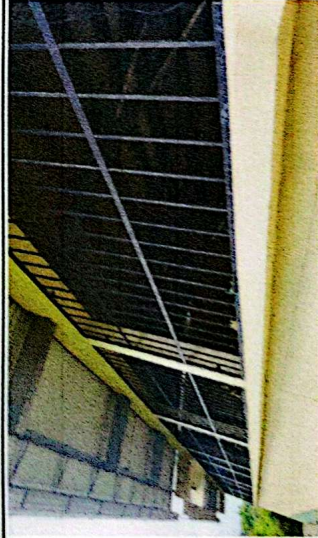
Foto 5: Mantenimiento a balcones
