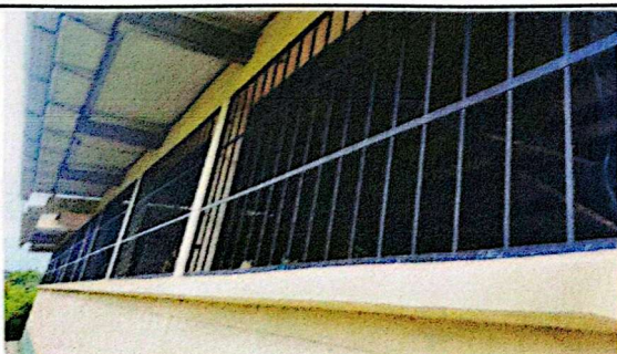
Foto 5: Mantenimiento a balcones
