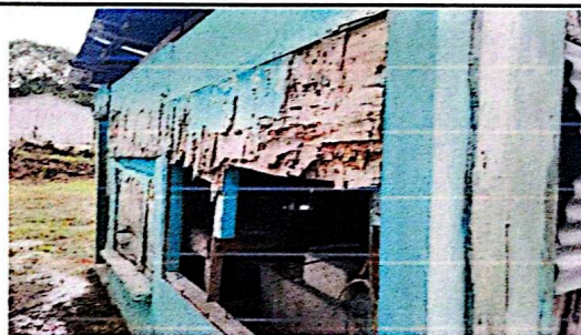
Foto 10: Sellado de grietas y fisura
