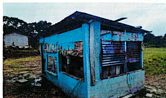
Foto 4: Sustrucion de Ventana
