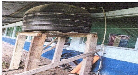
FOTO 10. SUSTITUCION DE DEPOSITO DE AGUA DE 1,700 LITROS
