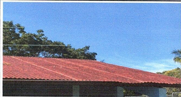
FOTO 1 SUSTITUCION DE LAMINA TROQUELADA ALUZINC CALIBRE 26
