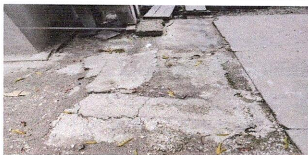
FOTO 5. SUSTITUCION DE PISO DE TORTA DE CONCRETO
