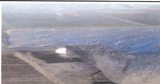
FOTO 12. SUSTITUCION DE PILA DE CONCRETO DE 2 LAVADEROS CO N CAPACIDAD DE 1,100 GALONES DE AGUA
