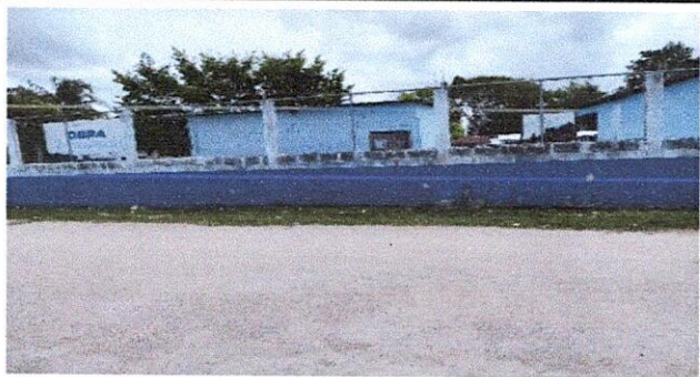
FOTO 7. PINTURA EN MUROS EXTERIORES E INTERIORES
