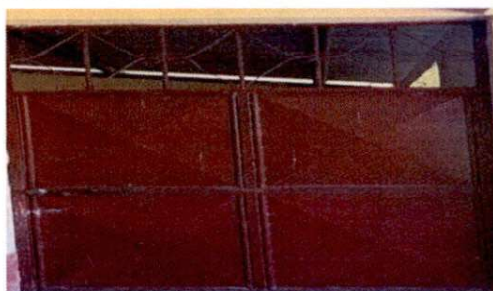
Foto 4: SUSTITUCION DE PUERTA
