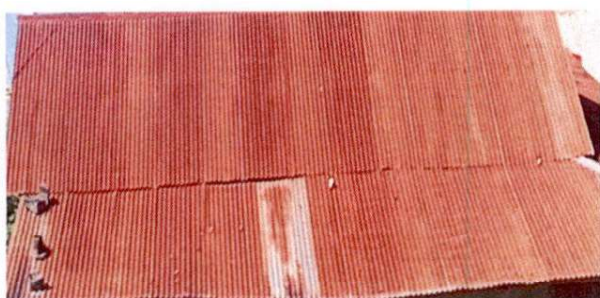
Foto 1: SUSTITUCION DE LAMINA POR LAMINA TROQUELADA ALUZING CALIBRE 26
