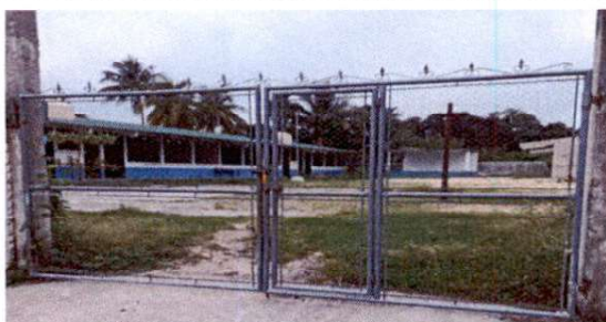
Foto 3: SUSTITUCION DE PORTON DE METAL
