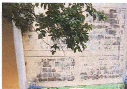
Foto 9: Pintura en muros exteriores e interiores.
