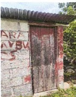
Foto 5: Sustitución de puerta en servicios sanitarios
