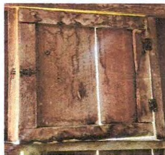
foto 6: Sustitución de ventanas de madera por metal
