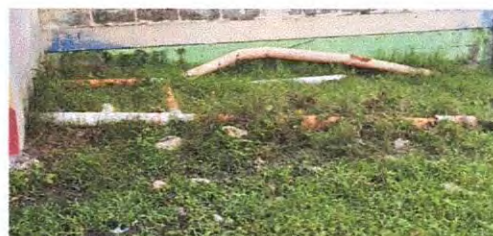
Foto 12: Sustitución de tubería PVC línea principal aguas negras
