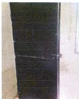
Foto: 3 Mantenimiento a estructura (lijado, cambio de tubo , cepillado, sujeciones, aplicación de pintura)
