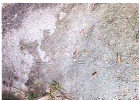
Foto 7: Reparación de piso de cemento líquido
