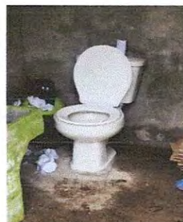
Foto 10: Sustitución de accesorios inodoro (contra llave, tubo de abasto y tanque)
