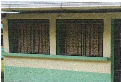
Foto 21: Mantenimiento a balcones de metal
