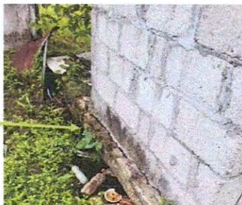
Foto 20: Mejoramiento de paredes, Sellado de grietas y fisuras en muros
