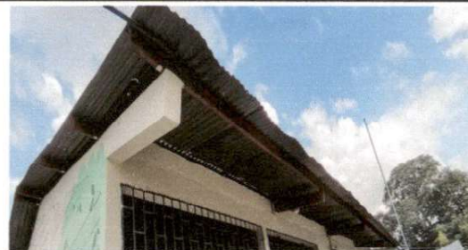
Foto 6: Mantenimiento a estructura de soporte de metal
