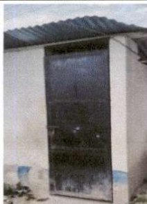
Foto 7: Mantenimiento a estructura (lijado, cambio de tubo, cepillado, sujeciones, aplicación de pintura) a puertas servicios sanitarios
