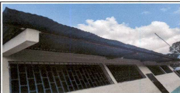
Foto 9: Mantenimiento a balcones de metal
