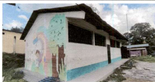
Foto 5: Pintura en muros exteriores e interiores
