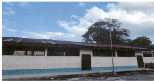
Foto 1: Sustrución de lamina, por lamina troquelada aluzinc calibre 26
