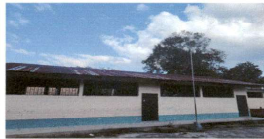
Foto 2: Sustrución de capote de lámina para lámina troquelada
