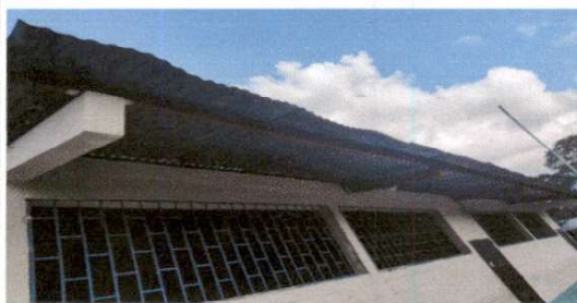
Foto 3: Sustrución de elementos de fijacion
