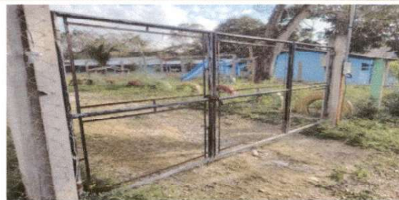
Foto 10: Mantenimiento a portones de metal
