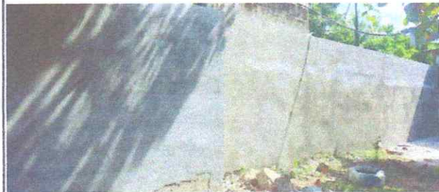
Foto 6: Reparación de muro perimetral de block
