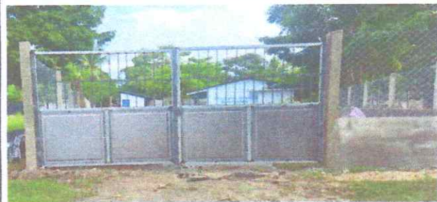
Foto 4: Fabricación e instalación de Portón de Ingreso
