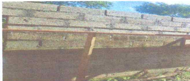
Foto 2: Reparación de muro perimetral de block con tubo hg y malla galvanizada, soleras intermedias y columnas.
