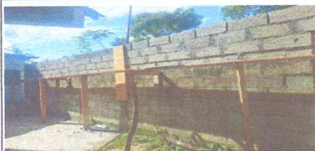
Foto 5: 15.1 Reparación de muro perimetral de block
