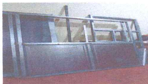
Foto 4: Fabricación e instalación de Portón de Ingreso
