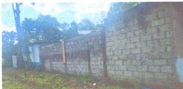
Foto 1: Reparación de muro perimetral de block
