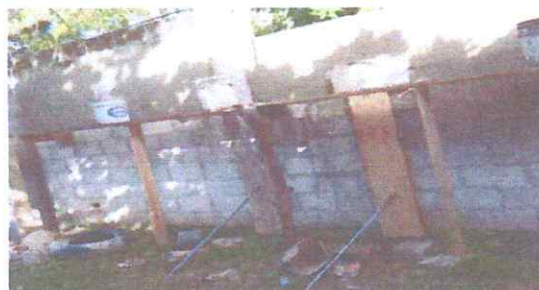
Foto 6: Reparación de muro perimetral de block
