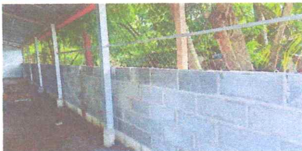
Foto 3: Reparación de muro perimetral de block con tubo hg y malla galvanizada, soleras intermedias y columnas.
