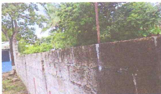
Foto 5: 15.1 Reparación de muro perimetral de block
