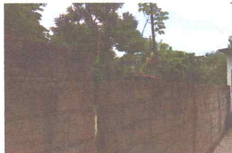
Foto 6: Reparación de muro perimetral de block
