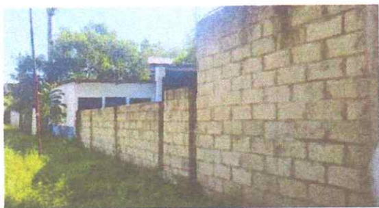
Foto 1: Reparación de muro perimetral de block
