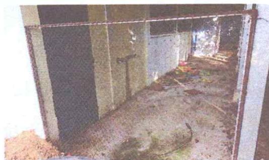
Foto 4: Fabricación e instalación de Portón de Ingreso
