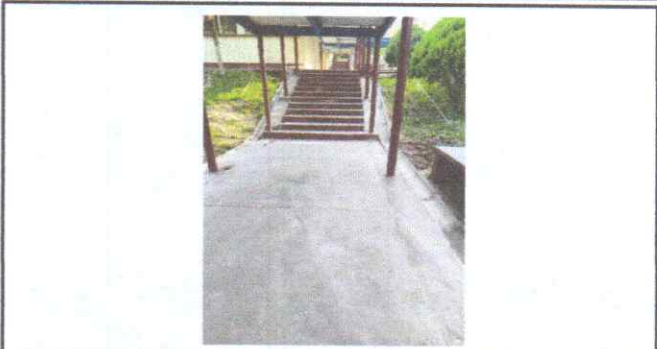
Foto: 2 Reparación de banquetas de concreto
