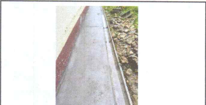
Foto 4 : Reparación de cuneta de concreto
