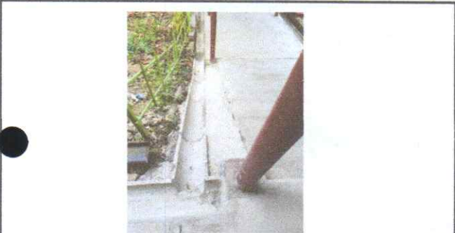
Foto: 5 Reparación de cunetas de concreto
