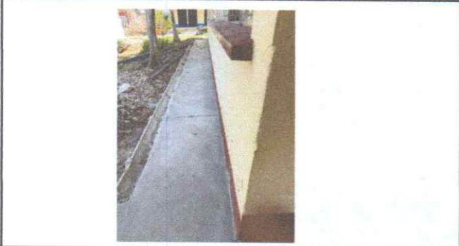
Foto 1: Reparación de banquetas de concreto
