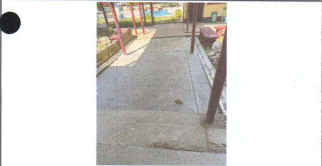
Foto: 3 Reparación de planchas de concreto de patio.
