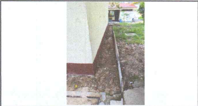
Foto 2: Reparación de banquetas de concreto
