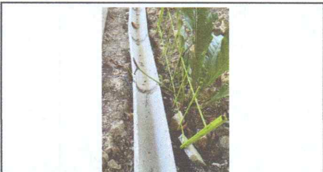
Foto 4: Reparación de cuneta de concreto
