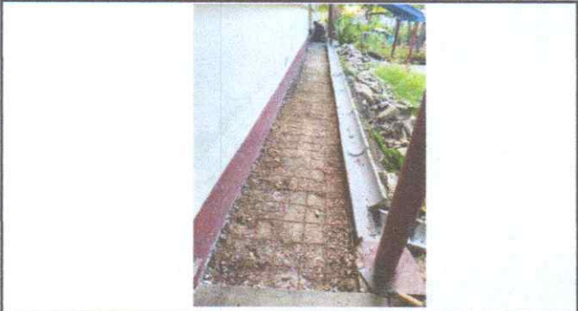
Foto 1: Reparación de banquetas de concreto
