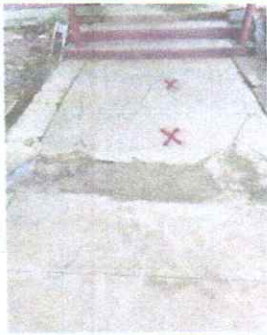
Foto 3: Reparación de planchas de concreto de patio
