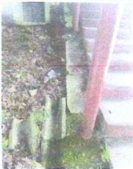
Foto 1: Reparación de cuneta de concreto
