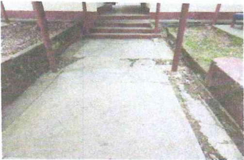
Foto 3: Reparación de planchas de concreto de patio.
