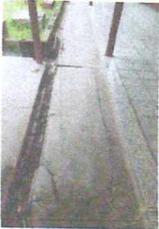
Foto 2: Reparación de banquetas de concreto
