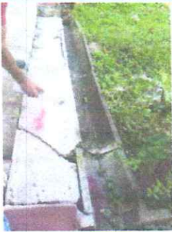
Foto 2: Reparación de banquetas de concreto
