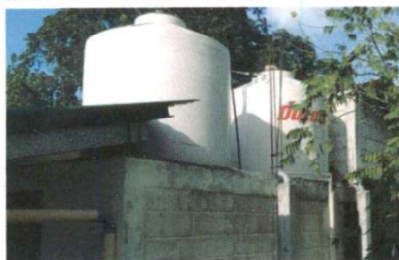
Sustitución de accesorios deposito de agua
