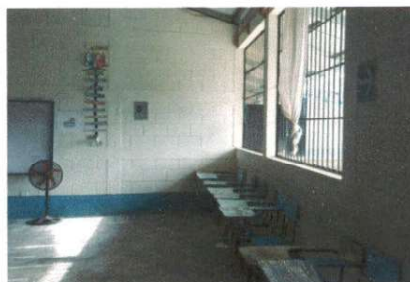
Pintura en muros exteriores e interiores
