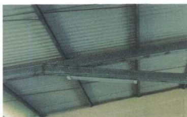
Instalación de unidades luz (incluye interruptor, ducto y cable eléctrico)
