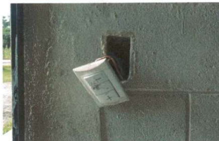
Instalación de unidades fuerza (tomacorriente), incluye cable eléctrico
