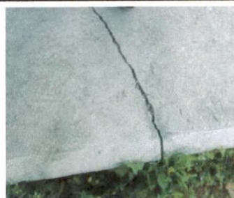
Reparación de banquetas de concreto
