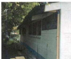
Sustitución de canal de pvc
