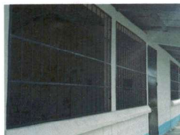
Mantenimiento a balcones de metal
