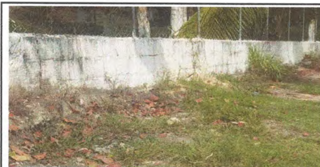
Foto 5: Pintura en muros exteriores e interiores
