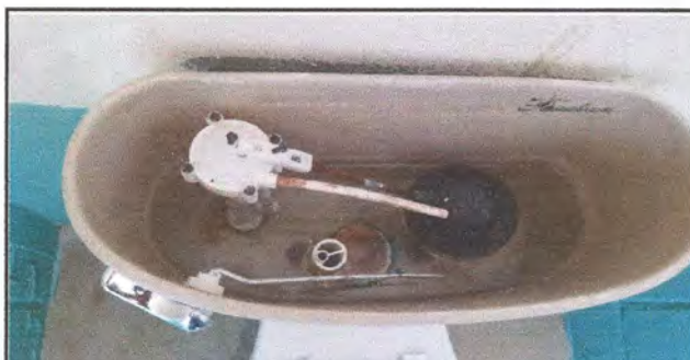
Foto 6: Sustitución de accesorios inodoros
