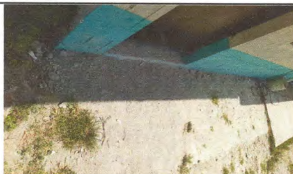
Foto 9: Reparación de plancha de concreto de patio
