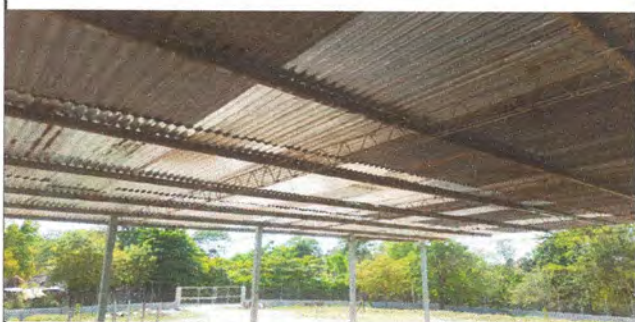
Foto 1: Sustitución de lámina por lámina troquelada
