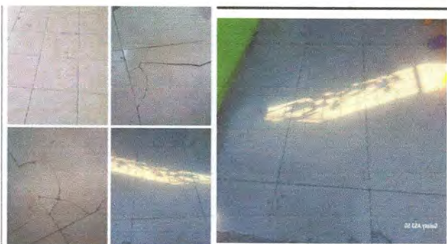
Foto 3: Reparación de piso cerámico
