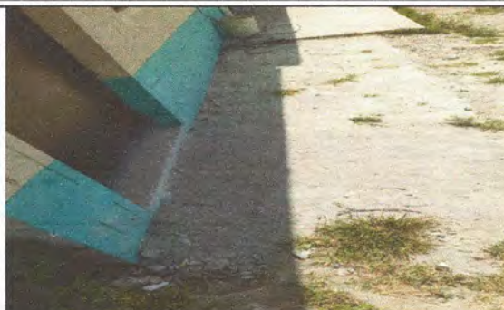
Foto 8: Reparación de plancha de concreto de patio
