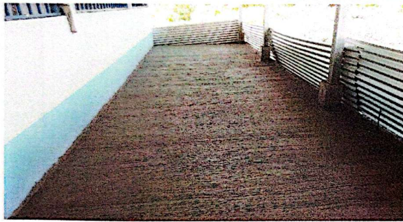
FORO 3. SUSTITUCION DE TORTA DE PISO DE CONCRETO.
