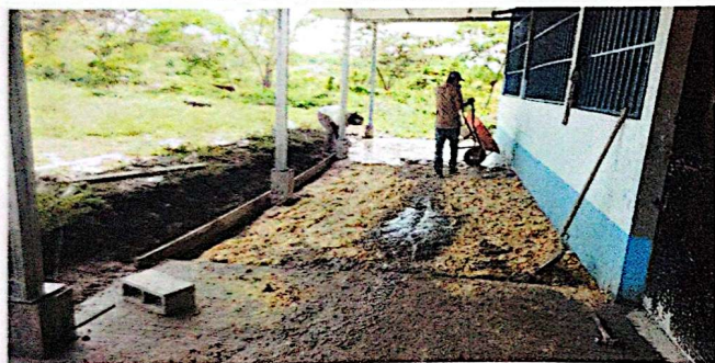
FOTO 3. SUSTITUCION DE PISO DE TORTA DE CONCRETO
