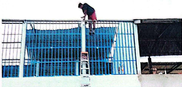
FOTO 1. SUSTITUCION DE LAMINA, POR LAMINA TROQUELADA ALUZIN CALIBRE 26
