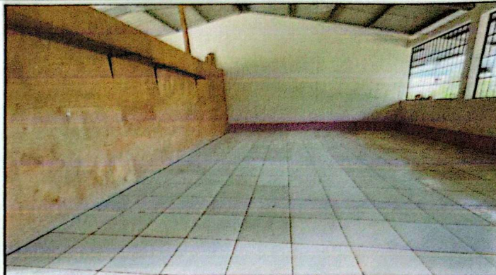
FOTO 2: Mejoramiento de piso de concreto a piso ceramico.
