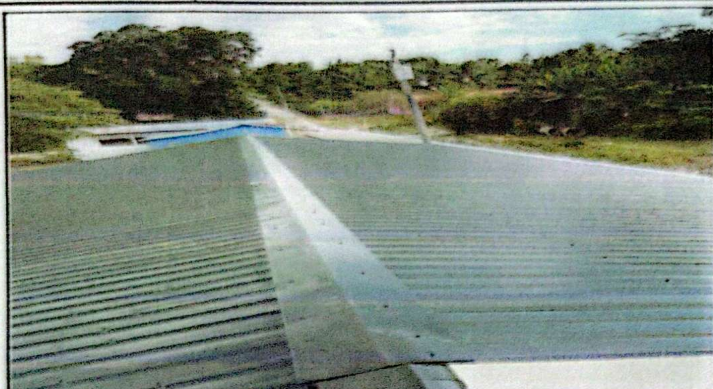
Foto 1: Mantenimiento de cubierta de lamina.
