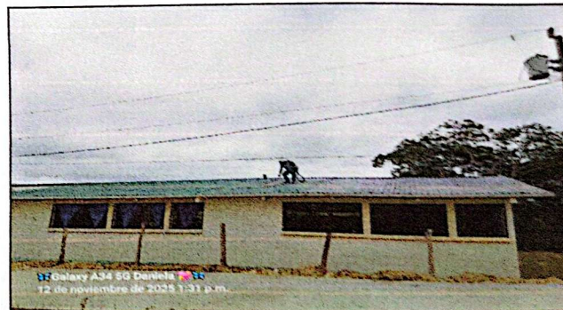
FOTO 4: Mantenimiento de Cubierta de Lamina
