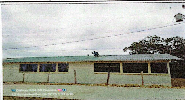
Foto 1: Mantenimiento de cubierta de lamina.
