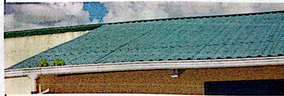
Foto 1: Mantenimiento a cubierta de lamina
