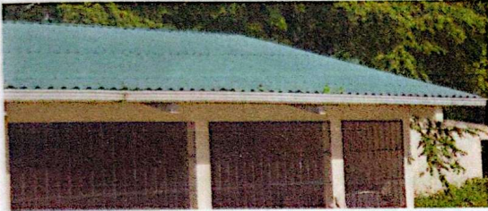
Foto 1: Mantenimiento a cubierta de lamina
