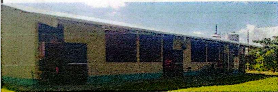
Foto: 3 Pintura en muros exteriores e interiores
