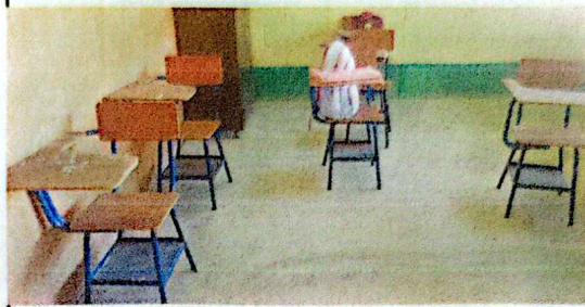
Foto: 2 Mejoramiento de piso de concreto a piso cerámico
