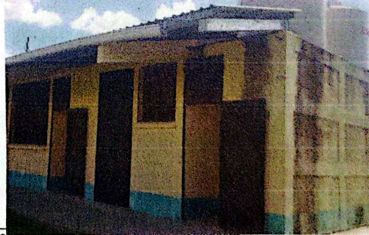
Foto: 3 Pintura en muros exteriores e interiores
