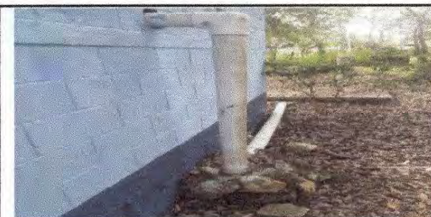
REPARACION DE TUBERIA PRINCIPAL DE DRENAJE
