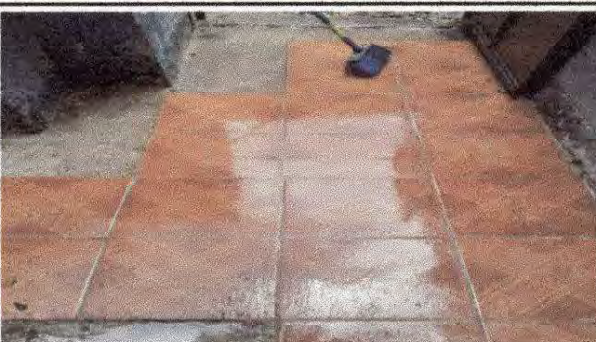
SUSTITUCIÓN DE CERÁMICO
