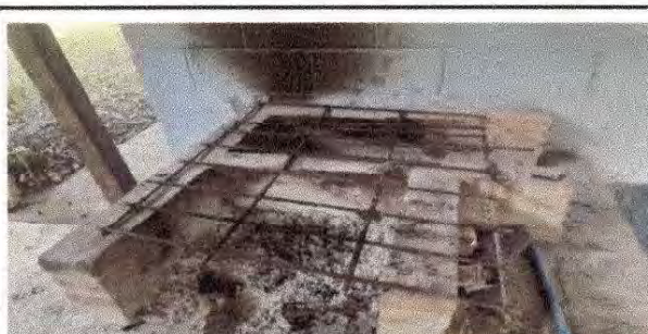
MANTENIMIENTO A ESTUFA RURAL
