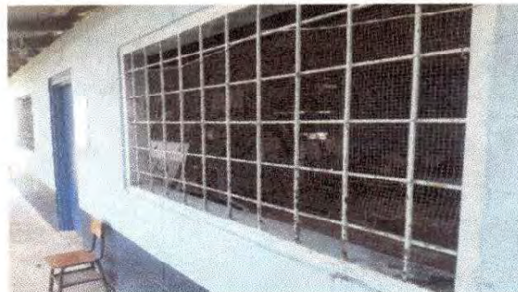
SUSTITUCIÓN DE BALCON DE METAL
