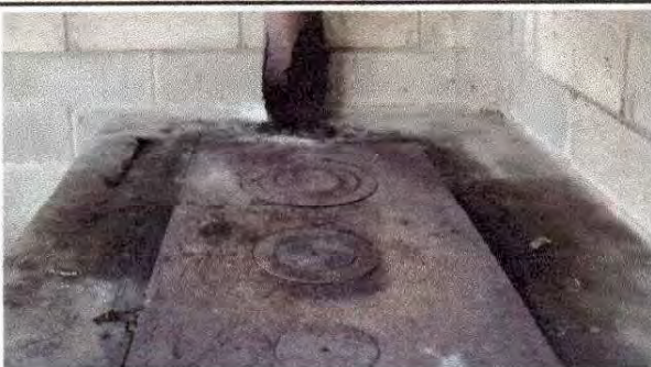
SUSTITUCIÓN DE PLANCHA DE METAL DE 3 HORNILLAS
