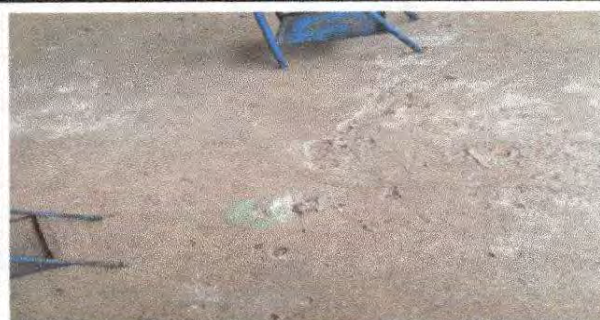
SUSTITUCION DE PISO DE TORTA DE CONCRETO
