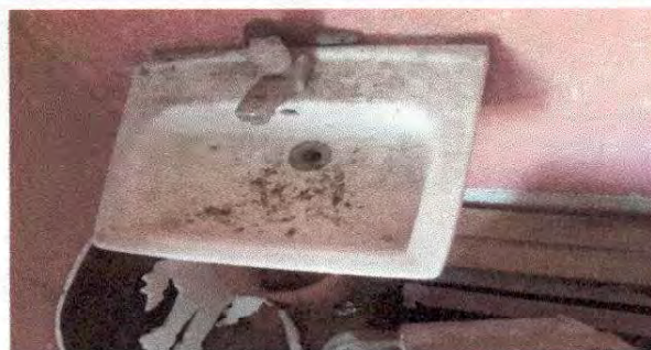
SUSTITUCIÓN DE LAVAMANOS
