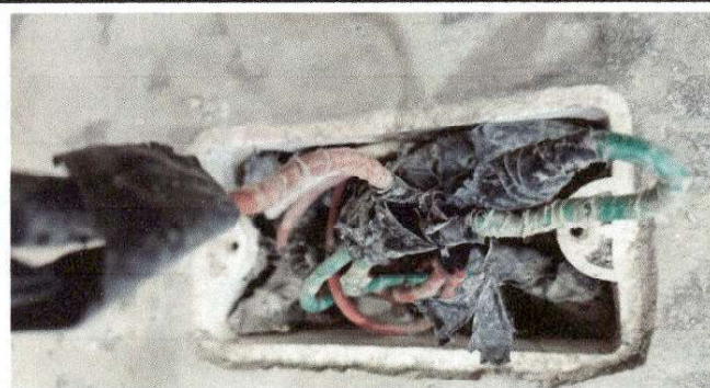
FOTO 4: Reparación de cableado eléctrico
