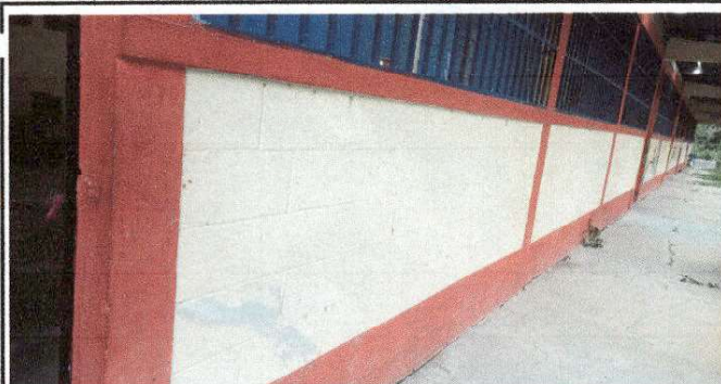
FOTO 3: Pintura en muros exteriores e interiores
