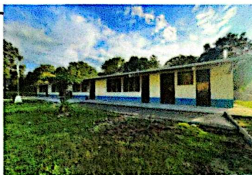
Foto 2: Finalización de la banqueta
