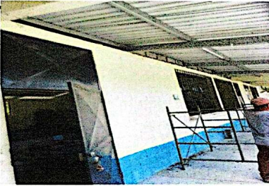
Foto 3: Repello de los blocs
