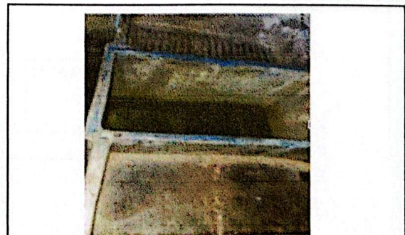
Foto 6: Instalación de pila. (Incluye drenaje)
