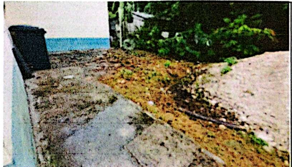
Foto 4: Sustitución piso torta de concreto
