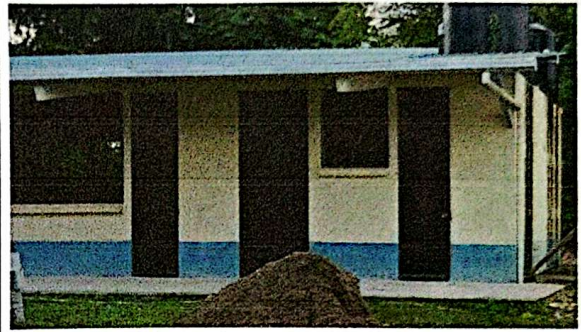
Foto 2: Pintura en muros exteriores e interiores
