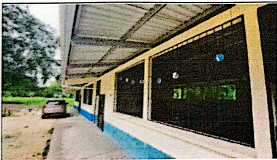
Foto 3: Fabricación e instalación de marcos de aluminio mil finish
