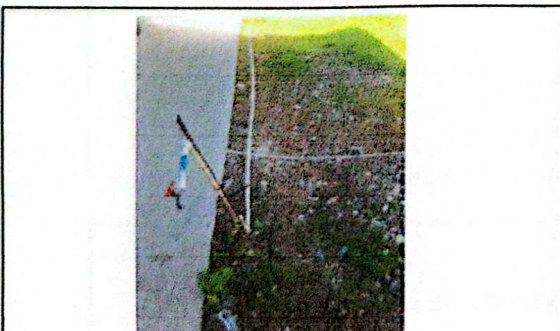
Foto 5: Instalación de tubería de pvc
