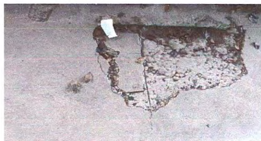
Foto 4: Sustitución de piso de torta de concreto
