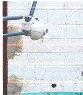
Foto 14: Instalación de unidades luz (incluye interruptor, ducto y cable eléctrico)
