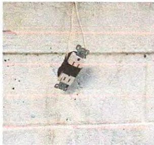
Foto 15: Instalación de unidades fuerza (tomacorriente), incluye cable eléctrico
