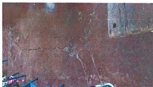
Foto: 3 Sustitución de piso de cemento liquido
