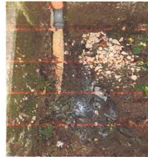
Foto 16: Sustitución de tubería PVC línea principal aguas negras
