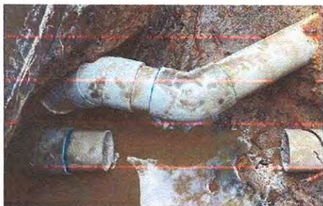
Foto 17: Instalación de tubería principal de pvc (Incluye accesorios)
