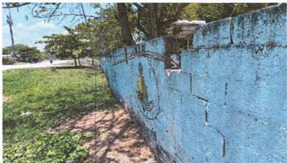
Foto1: Sustrucción de muro perimetral de block
