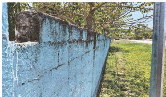
Foto 2: Pintura en muros exteriores e interiores
