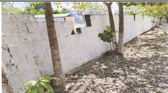
Foto 3: Sustrucción de muro perimetral de block
