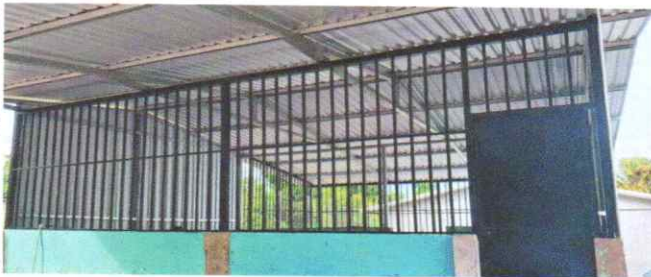
Foto 3: Sustrucción de balcones de metal
