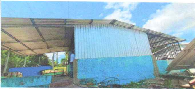
Foto 1: Sustrucción de lámina, por lámina troquelada aluzinc calibre 26, Sustrucción de capote de lámina para lámina troquelada
