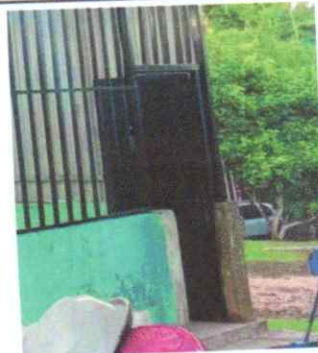
Foto 2: Sustrucción de puerta
