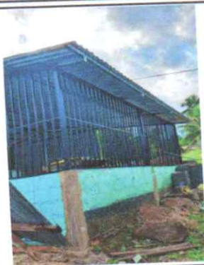
Foto 1: Sustrucción de lámina, por lámina troquelada aluzinc calibre 26, Sustrucción de capote de lámina para lámina troquelada
