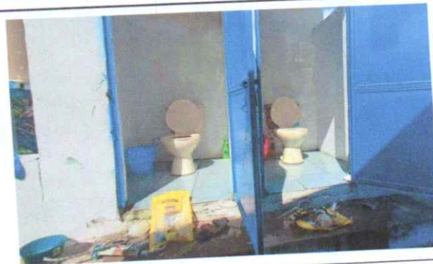
Foto 4: Sustrucción de accesorios inodoro (contra llave, tubo de abasto y tanque)
