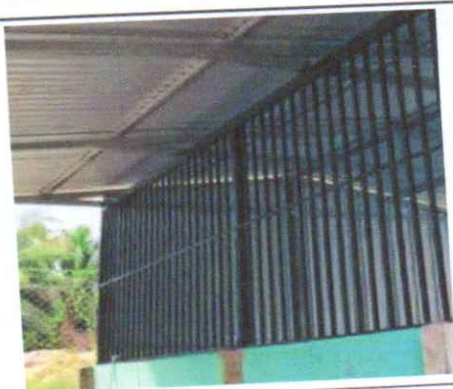
Foto 3: Sustrucción de balcones de metal
