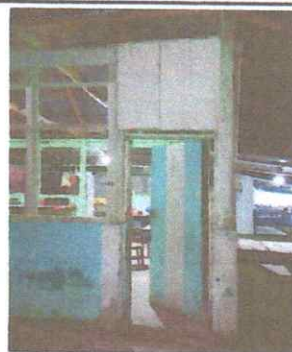
Foto 2: Sustitución de puerta
