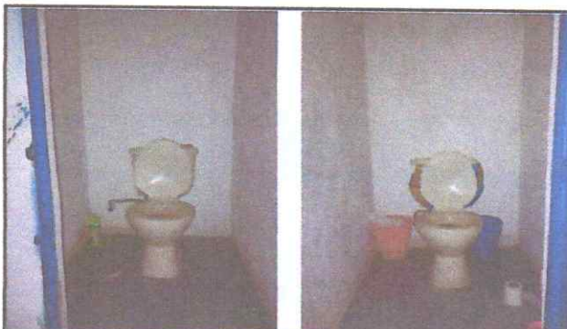
Foto 4: Sustitución de accesorios inodoro (contra llave, tubo de abasto y tanque)
