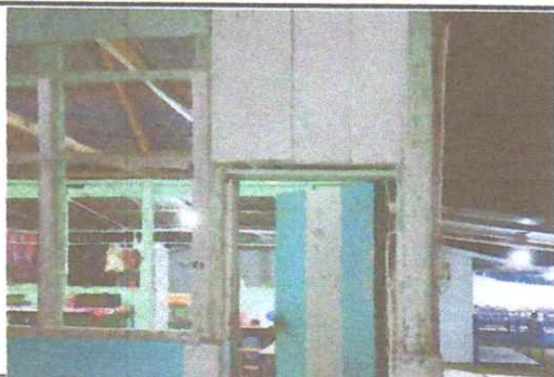
Foto 5: REPARACION DE SISTEMA ELECTRICO
