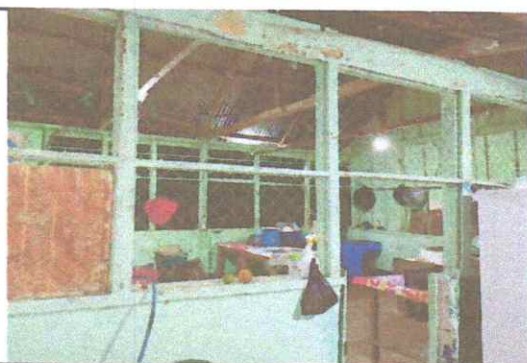
Foto 3: Sustitución de balcones de metal
