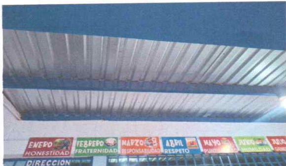
Foto 7: Mantenimiento a estructura de soporte de metal
