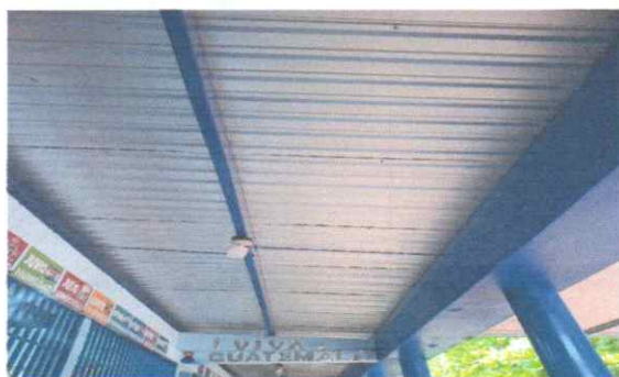
Foto 9: Sustitución de lámina, por lámina troquelada aluzinc 26
