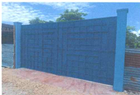
Foto 11: Reparación de dos muros, instalación de columnas, soleras
