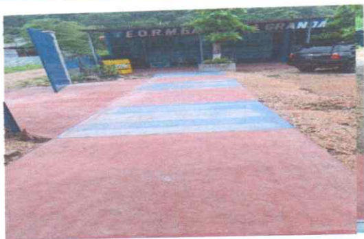
Foto 1: Sustrucción de piso torta de concreto al acceso de de baños
