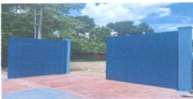
Foto 5: Sustrucción de portón de metal
