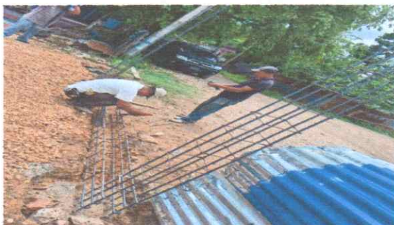
Foto 11: Reparación de dos muros, unсталación de columnas, soleras.
