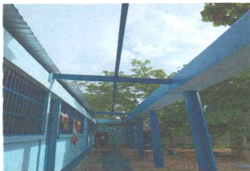
Foto 9: Sustitución de lámina, por lámina troquelada aluzinc calibre 26
