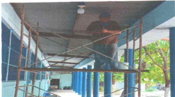
Foto 13: Pintura de metros lineales de muros
