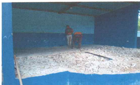
Foto 3: Sustrucción de torta de concreto a escenario
