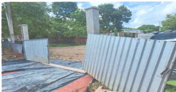
Foto 5: Sustrucción de Porton de metal
