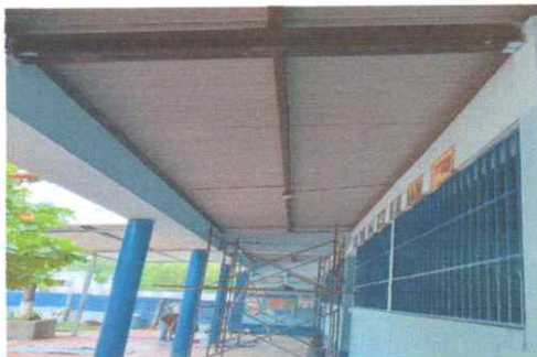
Foto 7: Mantenimiento a estructura de soporte de metal
