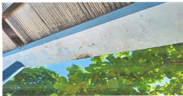
Foto 10: sustitución de lámina
