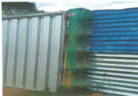
Foto 11: Reparación de muros, instalación de columnas, soleras.
