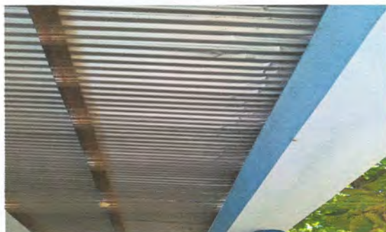
Foto 7: Mantenimiento a estructura de soporte de metal
