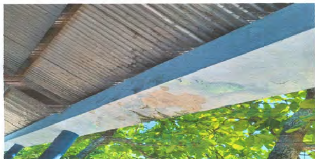
Foto 9: Sustitución de lámina, por lámina troquelada calibre 26
