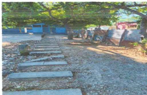
Foto 1: Sustrucción de piso torta a acceso al baño de niños y niñas
