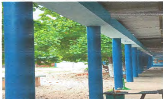
Foto 13: Pintura de muros en los corredores de la escuela
