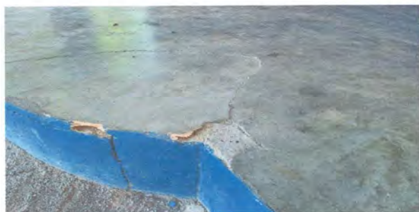
Foto 3: Sustrucción de torta de concreto en Escenario
