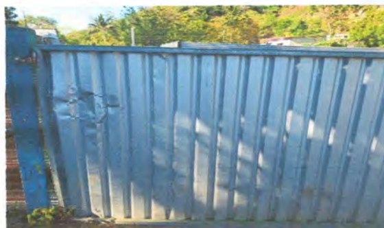
Foto 6: Sustrucción de porton de metal
