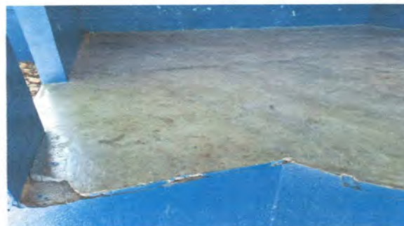
Foto 4: Sustrucción de torta de concreto en Escenario
