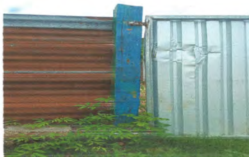
Foto 12: Reparación de muros
