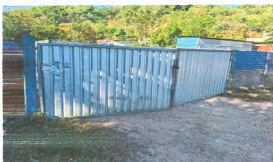
Foto 5: Sustrucción de Porton de metal
