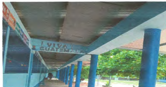
Foto 14: Pintura de muros
