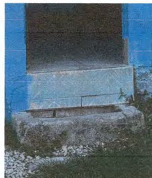
FOTO 8: REPARACIÓN DE PLANCHAS DE CONCRETO EN PATIO
