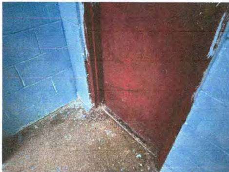
FOTO 7: SUSTITUCIÓN DE PISO DE TORTA DE CONCRETO
