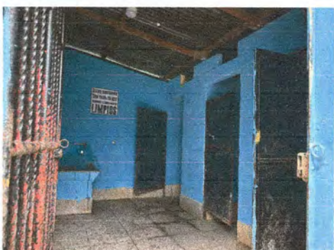
FOTO 3: SUSTITUCIÓN DE PUERTA EN SERVICIOS SANITARIOS
