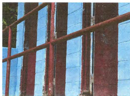
FOTO 6: SUSTITUCIÓN DE BARANDAS DE METAL
