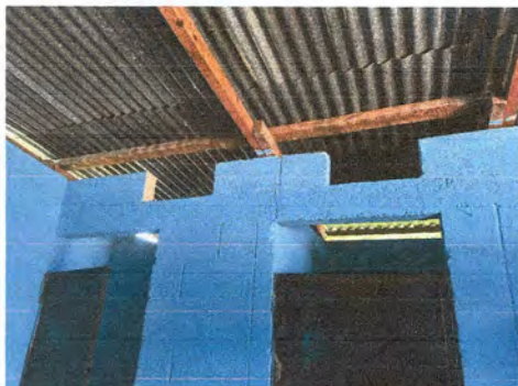
FOTO 1: SUSTITUCIÓN DE LÁMINA TROQUELADA CALIBRE 26
