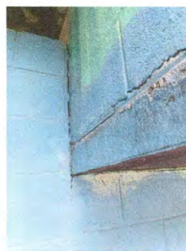
FOTO 10: MUROS PERIMETRALES EN SERVICIOS SANITARIOS
