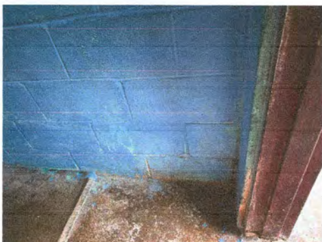
FOTO 9: REPELLO DE MUROS
