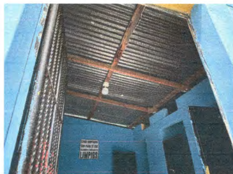
FOTO 2: SUSTITUCIÓN DE ESTRUCTURA DE MADETA, POR METAL
