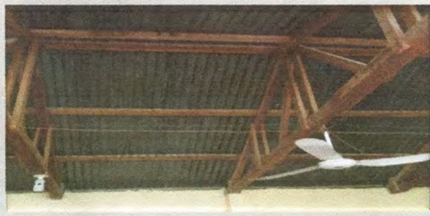
Foto 1: SUSTITUCION DEL CABLEADO ELECTRICOS DE AULA No.1
