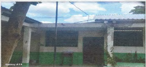
Foto 6: LEVANTADO DE LÁMINA SOBRE TERRASITA, PARA EVITAR HUMEDAD
