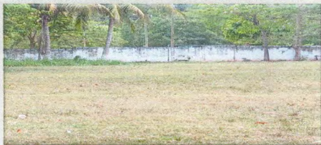
Foto 5: LEVANTADO DEL MURO PERIMETRAL 3 NIVELES DE BLOCK (ESTO SI ALCANZARA EL PRESUPUESTO)
