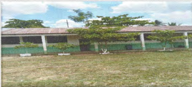
Foto 4: SUSTITUCIÓN Y REPARACIÓN DEL SISTEMA ELECTRICO DE 2 AULAS Y BAÑO DE NIÑAS
