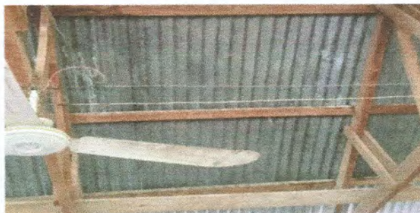
Foto 4: SUSTITUCIÓN DEL CABLEADO ELECTRICO DE AULA No.2
