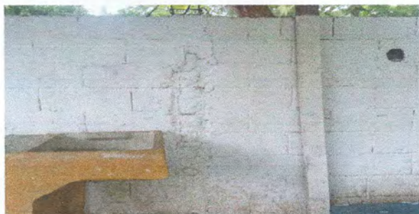
Foto 5: LEVANTADO DEL MURO PERIMETRAL 3 NIVELES DE BLOCK
