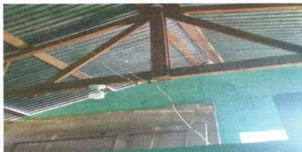
Foto 2: SUSTITUCIÓN DEL CABLEADO ELECTRICO DEL BAÑO DE NIÑAS
