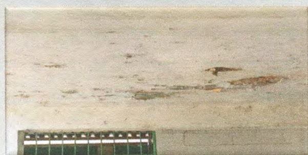
Foto 3: SELLADO DE GRIETA Y FISURA DEL MURO (TERRASITA) FRENTE A DIRECCION
