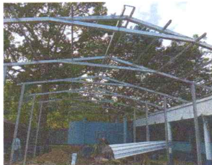
Foto 2: estructura de soporte de metal
