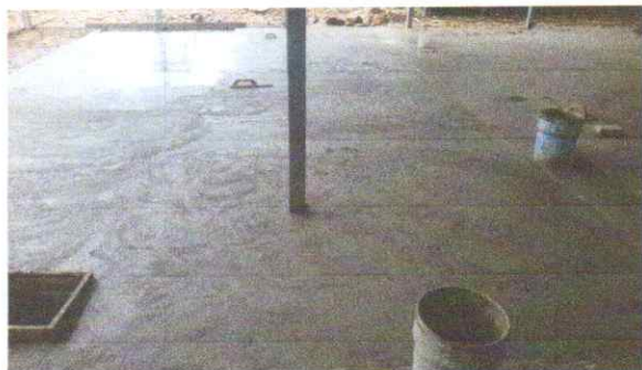
Foto 3: Sustitucion de piso de torta de concreto
