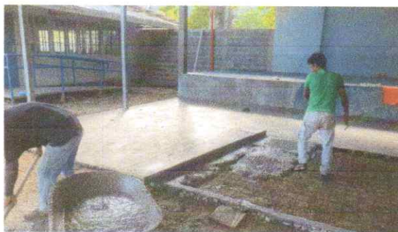
Foto 3: Sustitucion de piso de torta de concreto
