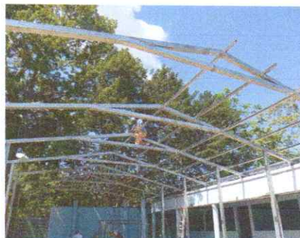
Foto 2: estructura de soporte de metal
