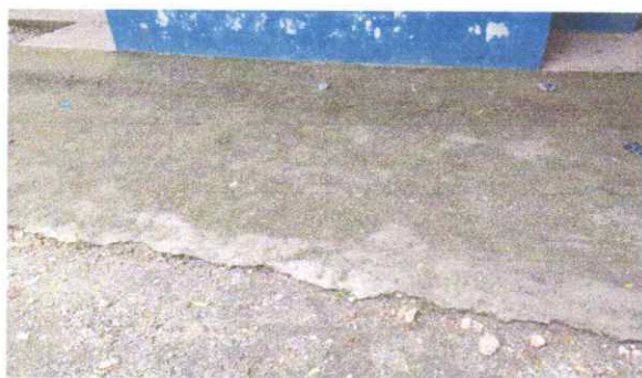
Foto 3: Sustitucion de piso de torta de concreto
