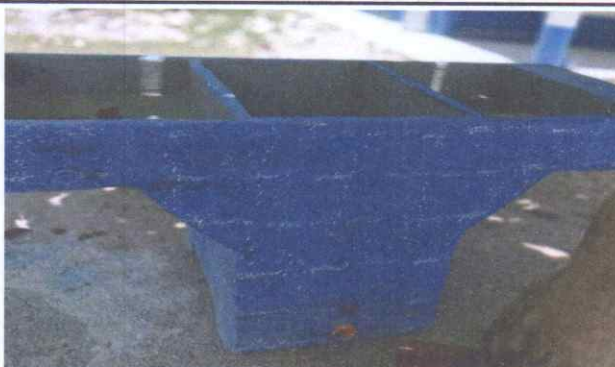
Sustitución de pila de cemento de 2 lavaderos
