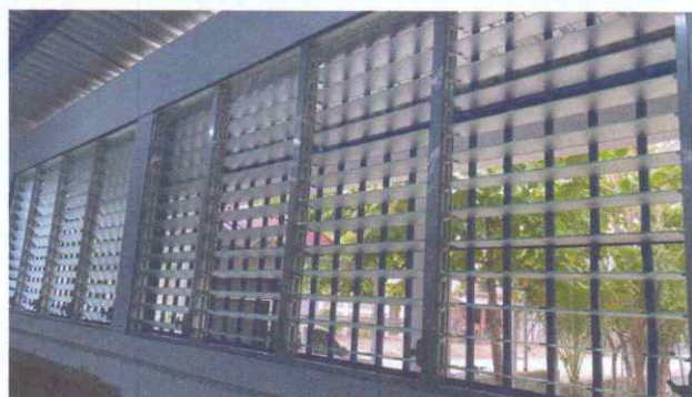
Sustitución de ventanas de madera por metal mas vidrio
