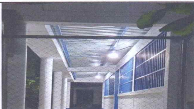
Desinstalación de lámina existente
