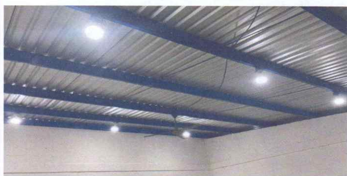
Instalación de unidades de luz (incluye interruptor, ducto y cable electrico)
