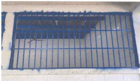
Mantenimiento a balcones de metal
