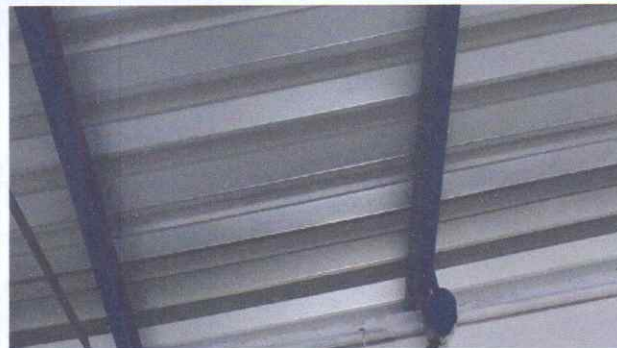
Sustitución de elementos de fijación
