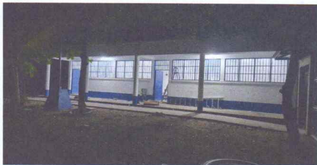
Pintura en muros exteriores e interiores
