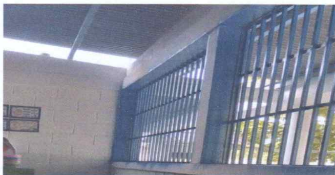
Sustitución de balcones de metal
