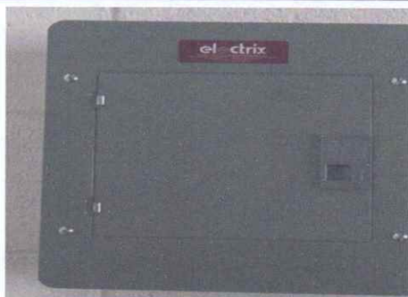
Sustitución de tablero de flipones
