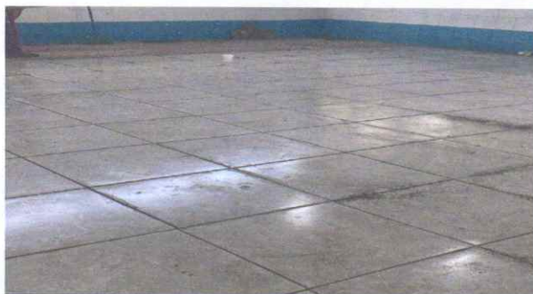
Sustitución de piso ceramico
