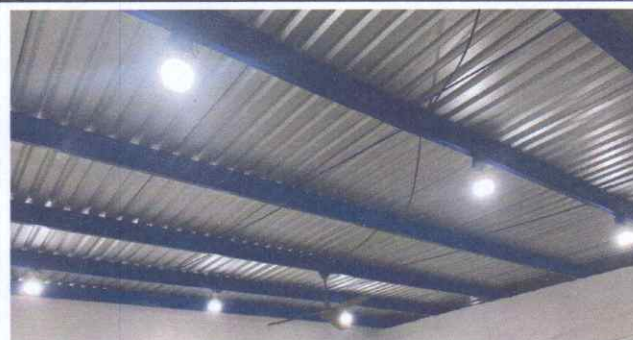
Mantenimiento a estructura de soporte de metal
