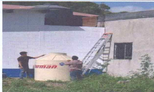
Sustitución de deposito de agua 1700 Lts
