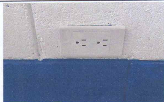
Instalación de unidades de fuerza (tomacorriente) incluye cable electrico
