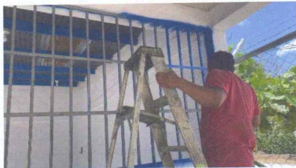
Sustitución de balcones de metal
