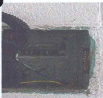
Sustitución de tablero de flipones
