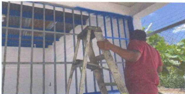
Mantenimiento a balcones de metal
