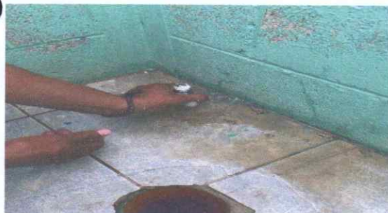
Sustitución de inodoros
