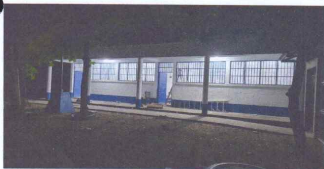
Pintura en muros exteriores e interiores
