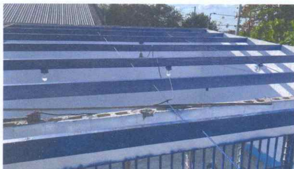
Desinstalación de lámina existente
