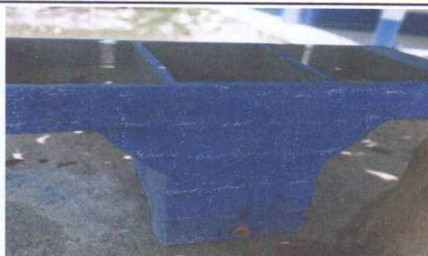
Sustitución de pila de cemento de 2 lavaderos
