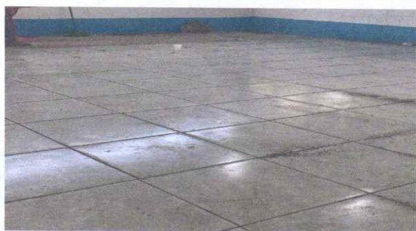
Sustitución de piso ceramico
