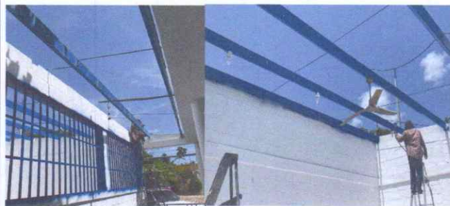
Mantenimiento a estructura de soporte de metal
