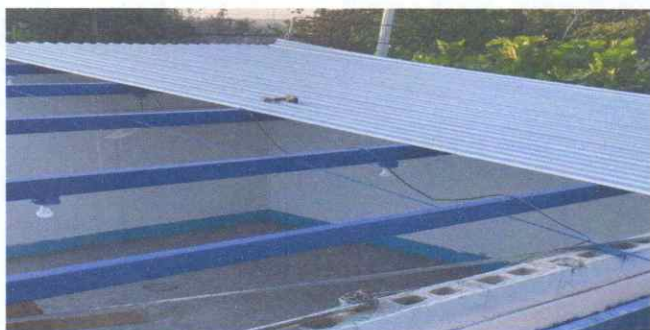
Sustitución de lámina por lámina troquelada aluzinc calibre 26
