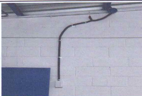
Instalación de unidades de luz (incluye interruptor, ducto y cable electrico)
