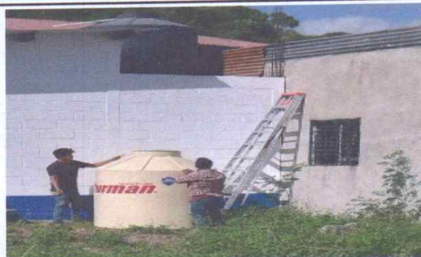
Sustitución de deposito de agua 1700 Lts
