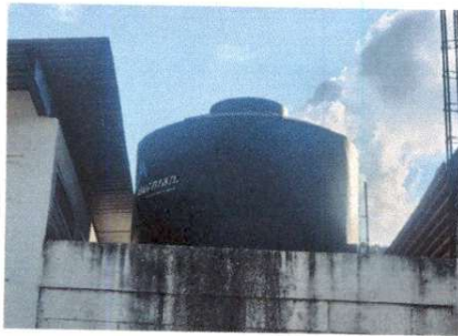
Foto 7: Sustitución de deposito de agua 1700 lt
