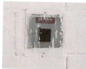
Foto 10: Sustitución de tablero de flipones
