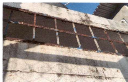
Foto 6: Sustitución de balcones. ✓
