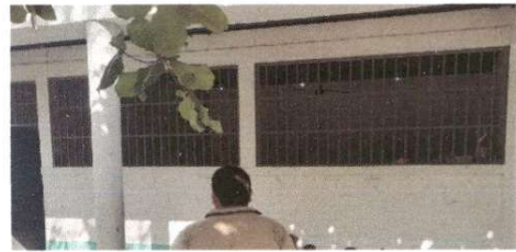
foto 16: Pintura en muros exteriores e interiores ✓
