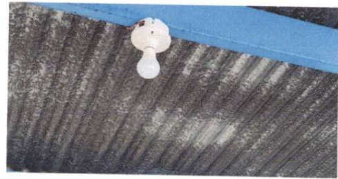
Foto 8: Instalación de unidades luz (incluye interruptor, ducto y cable eléctrico)
