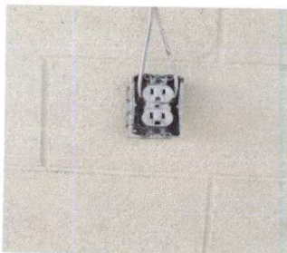
Foto 9: Instalación de unidades fuerza (tomacorriente), incluye cable eléctrico
