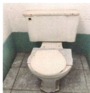
Foto 4: Sustitución de inodoros ✓
