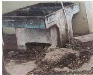
Foto 15: Sustrucción de pila de cemento de 2 lavaderos ✓
