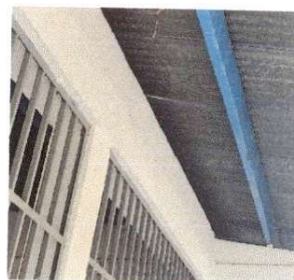
Foto 12: Mantenimiento a Balcones de Metal
