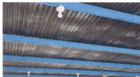
Foto 2: Mantenimiento a estructura de soporte de metal ✓
