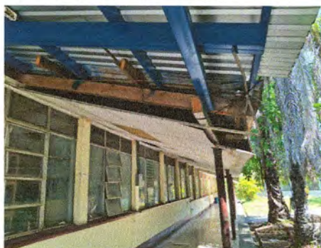
Foto: 3 Sustitución de estructura de soporte de madera, por metal
