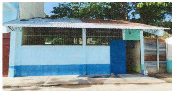
Instalación de lámina troquelada aluzinc
