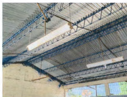
Sustitución de ducto eléctrico + accesorios
