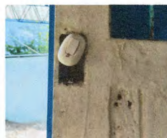
Sustitución interruptores simples
