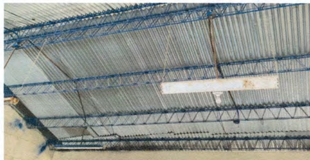
Reparación de lámparas
