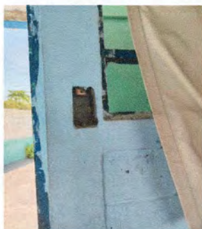
Sustitución de tomacorrientes dobles
