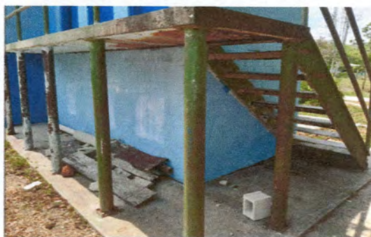
Foto: 11 Mantenimiento a barandas de metal.
