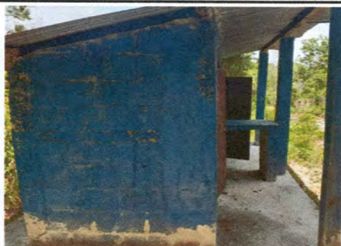
Foto: 9 Pintura en muros exteriores e interiores
