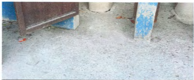
Foto 7: Sustitución de piso de cemento liquido
