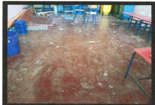
Foto: 8 Sustitución de piso liquido.
