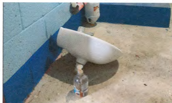
Foto: 10 Sustitución de lavamanos
