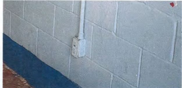
Foto 14: Instalación de unidades fuerza (tomacorriente), incluye cable eléctrico
