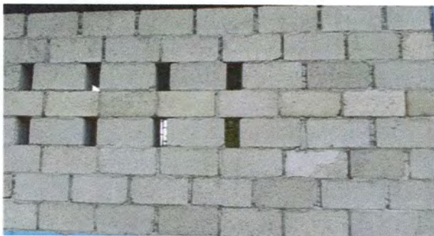
Foto 15: Cermido en muros
