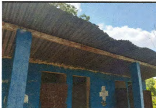
Foto 2: Sustrucción de estructura de soporte de madera, por metal.
