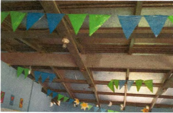
Foto 13: Instalación de unidades luz (incluye interruptor, ducto y cable eléctrico)
