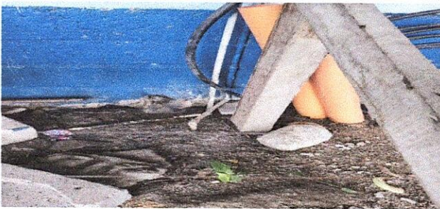
FOTO 5. SUSTITUCION DE TUBERIA PRINCIPAL AGUAS NEGRAS
