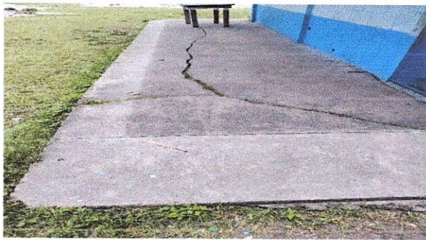
FOTO 3. SUSTITUCION DE PISO DE TORTA DE CONCRETO
