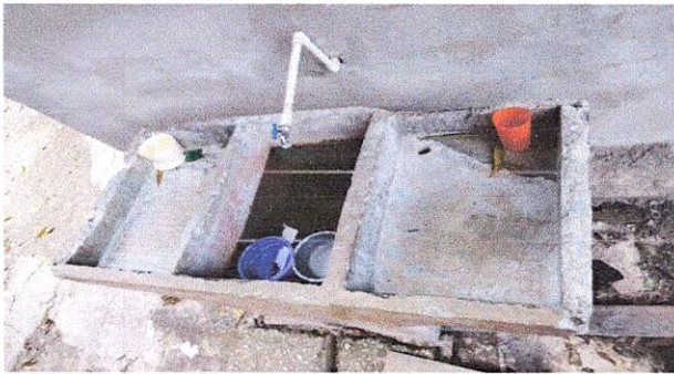
FOTO 7. SUSTITUCION DE PILA DE CEMENTO DE 2 LAVADEROS CON CAPACIDAD DE 1,100 LITROS DE AGUA
