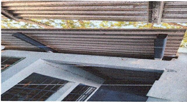
FOTO 1. SUSTITUCION DE ESTRUCTURA DE SOPORTE DE METAL, POR METAL
