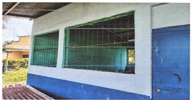
FOTO 2. SUSTITUCION DE BALCON DE METAL
