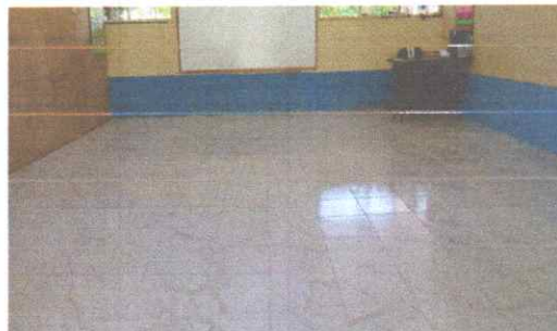
Foto 4: Mejoramiento de piso de cemento liquido a piso cerámico
