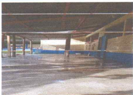
Foto 3: Sustitución de piso de torta de concreto
