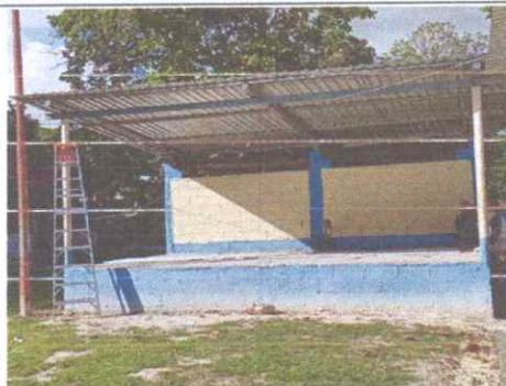
Foto 2: Sustitución de lámina por lámina troquelada de aluzinc calibre 28
