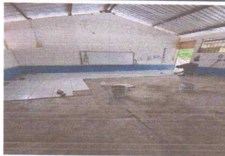
Foto 4: Mejoramiento de piso de cemento liquido a piso cerámico
