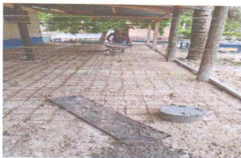
Foto 3: Sustitución de piso de torta de concreto
