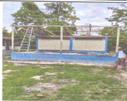
Foto 2: Sustitución de lámina por lámina troquelada de aluzinc calibre 26
