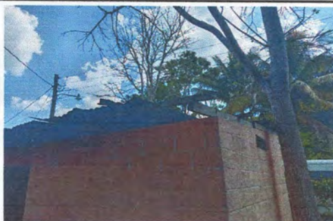
Foto 1: Sustrucción de estructura de soporte de madera por metal
