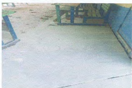
Foto 3: Sustrucción de piso de torta de concreto
