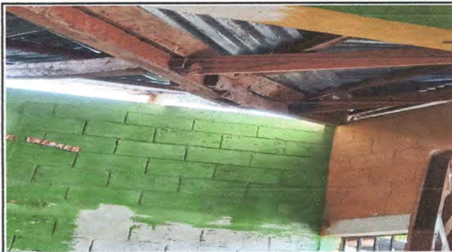
Foto: 4 Sustitución de canal de metal
