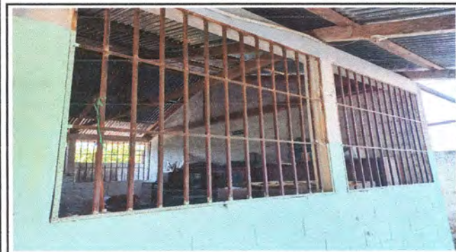
Foto: 3 Mantenimiento a balcones de metal.
