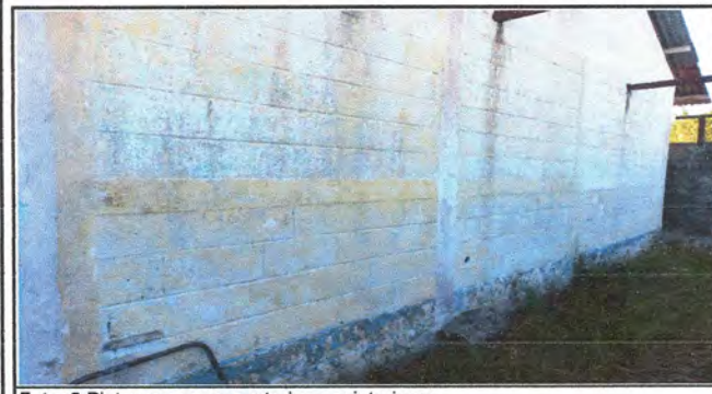
Foto: 5 Pintura en muros exteriores e interiores.
