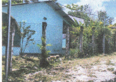
Foto 2: REPARACIÓN DE INTERMEDIAS Y COLUMNAS
