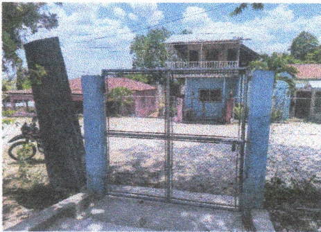
Foto 3: FABRICACIÓN E INSTALACIÓN DE PORTON DE METAL DE INGRESO
