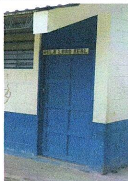
Foto 2: Sustitución de puertas
