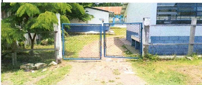
Foto 3: Sustitución de portón de metal
