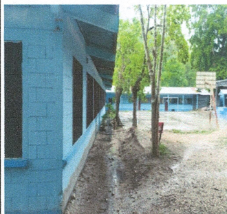
Foto 5: La siguiente imagen muestra la parte donde se realizara una instalación y uministro de plancha de concreto de patio para evitar la filtración del agua ya que por ser aulas antiguas se filtra el agua con las lluvias
