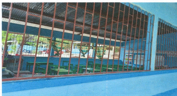
Foto 4: como se observa en la foto los valcones que realizara lijado y pintado para evitar que se sigan deteriorando
