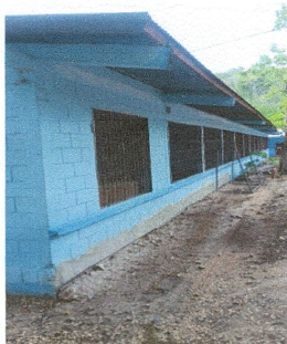
Foto 5: La siguiente imagen muestra la parte donde se realizara una instalación y uministro de plancha de concreto de patio para evitar la filtración del agua ya que por ser aulas antiguas se filtra el agua con las lluvias
