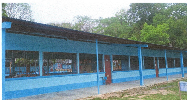
Foto 3: tercer angulo en esta parte se puede observar la lámina que se estara quitando para dicho remozamiento
