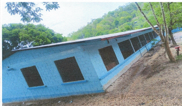
Foto 1: Este es un angulo donde se puede observar el techo que se estara trabajando que son 4 aulas y direccón solo se realizara cambio de techo ya que el soporte de metal solo se estara lijando y pintando.
